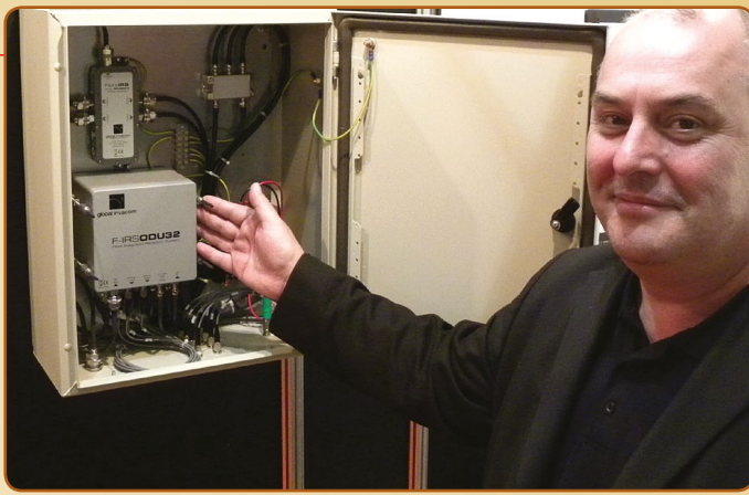
■ GlobalInvacom的新产品：一个装备着四个堆叠的ODU32组件可以提供八个相同的光学连接，最多为256个用户提供连接。
