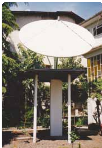
■ 完成! 天线被固定好
