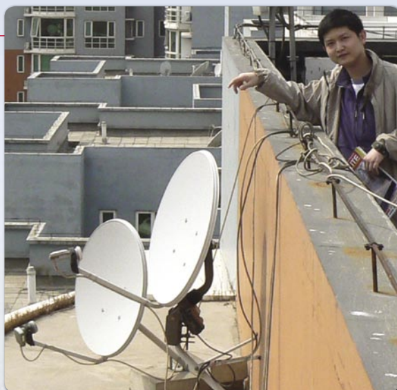
■ 其它天线被安装在旁边的护墙上: 75 cm 天线对着 134 ° E, 而 60 cm 天线则装有 MOTECK 的极轴座。
