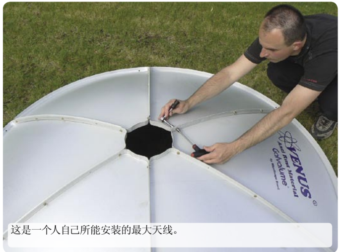
天线面通过折弯的侧面连接在一起，增加了强度
