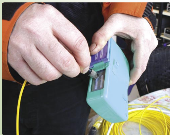
给所有安装者的提示: 光缆连接不只是简单地接在一起, 之前要处理得非常干净才行。可以使用各种不同的方法来弄干净。实际上最常见是用这里显示的装置: 将光纤接头插入, 然后用一张一次性的非常细的砂纸来研磨清理接头。这是保证连接没有任何信号衰减唯一的方法。
