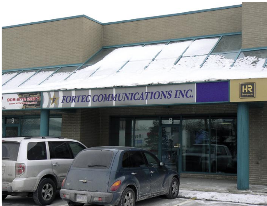
第 8 单元是天际大街2780号长长的商业建筑的一部分，它与东西走向的主街艾哥林顿大街平行，Fortec Star 的办公室就在这里。商店则位于一个提供综合服务的复杂综合性建筑物内。
